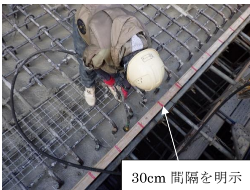
図-11 小径バイブレーターによる締固め
