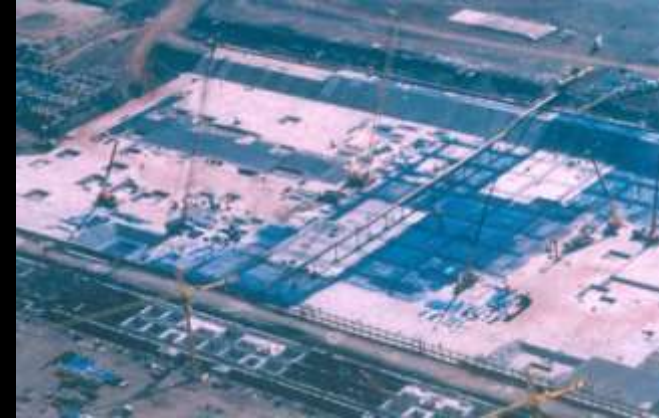
関西空港でのエポキシ樹脂塗装鉄筋の利用
