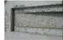
過去の試験施工によって、通常パイプレータで締固めた場合、路面排水樹の下面には気泡が残ることが確認されている
