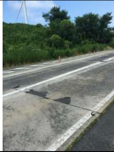
国道9号北条バイパス 施工目地区間
