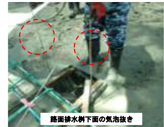
過去の試験施工によって、通常パイプレータで締固めた場合、路面排水樹の下面には気泡が残ることが確認されている
