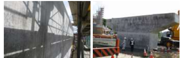
沖縄総合事務局南部国道事務所での橋脚の品質確保の試行
