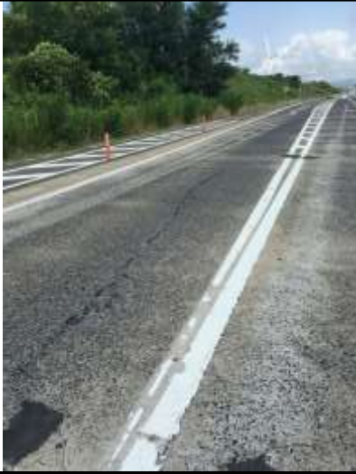
国道9号北条バイパス 施工目地区間
