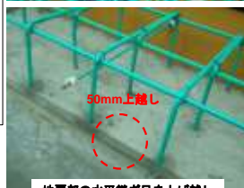
地覆部の水平継ぎ目を上げ越し
