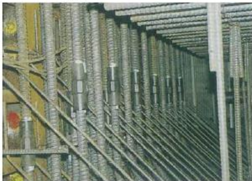
地下構造物施工例
